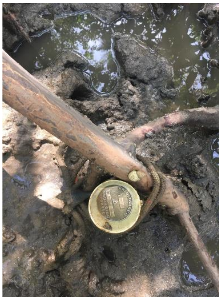
Figura 3: Implantação dos marcos geodésicos com a referência.
